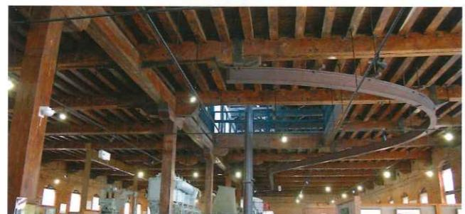
隣の鋳物工場への運搬に使用されたレールも残っている。
